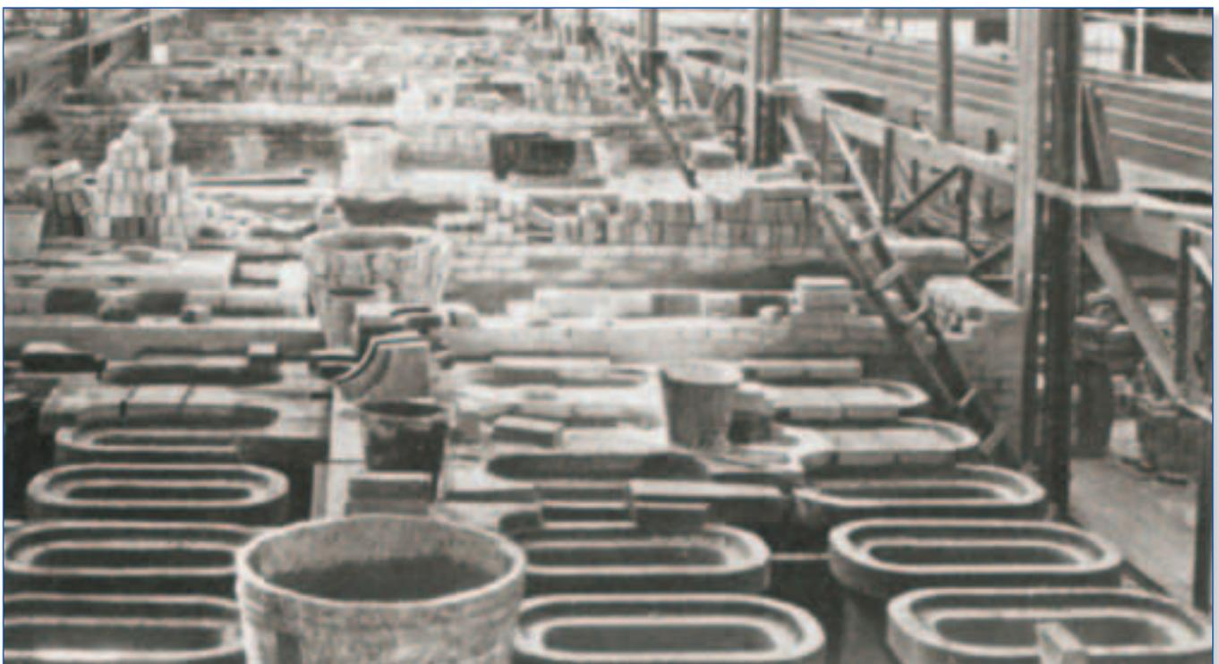
Einbau von vertikal angeordneten Schamotteretorten in einem städtischen Gaswerk.
